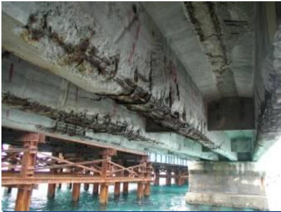
塩害による鉄筋の腐食:国総研木村嘉富氏提供
