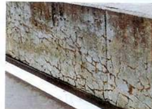
写真-2 パターンひび割れ 2)
