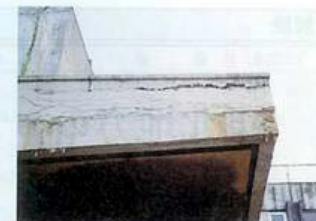
写真-3 長手方向ひび割れ 2)
