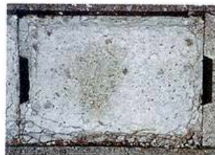
写真-1 Dひび割れ 2)
