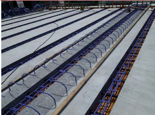
不動沢橋 L = 19 m 間詰コンへのフライッシュ適用 (2015年8月)
