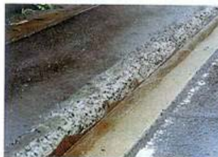
写真-4 スケールン 2)
