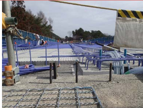
大沢第3橋 L = 71 m プレキャスト部材との合成場所打ち フライッシュ床版 (2016年4月)
