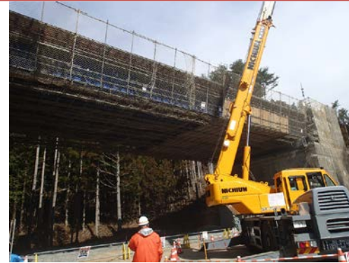
浪板橋 L = 38 m フライッシュコン&平坦仕上げ (2016年4月)
