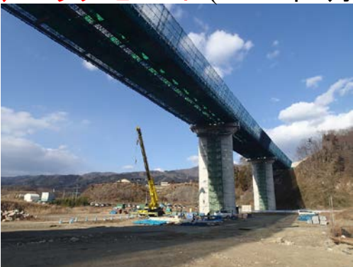
新気仙大橋 L = 438 m 高炉スラグセメント (2016年5月)
