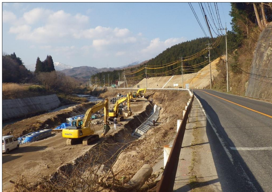
地域高規格道路 北条湯原道路 国道 3 1 3 号 初和下長田道路 (美作県民局真庭地域)
