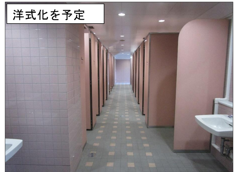
岡山県総合グラウンドのトイレの改修
