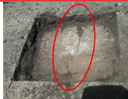
中空床版上面ボイド位置ひび割れ
