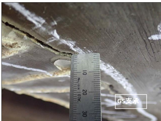
ひびわれ幅1.2mm, ひびわれの段差1.0mm
