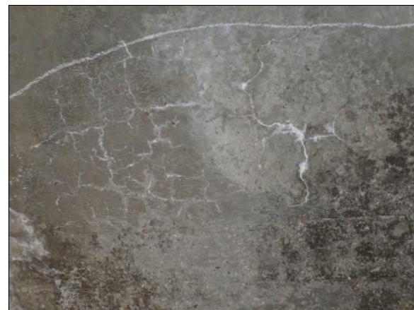
橋面上の損傷状況
