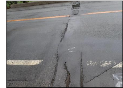
伸縮装置 の状況
