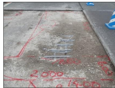
床版上面の開削・ 脆弱部撤去状況
