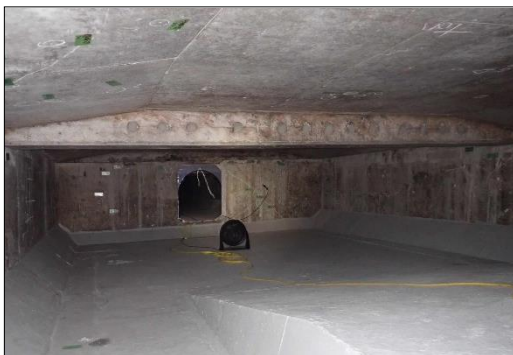
箱桁内状況写真
