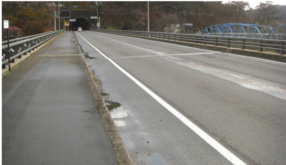
舗装打継ぎ目の工夫
