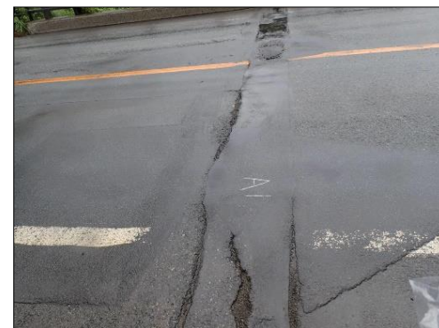
伸縮装置の状況
