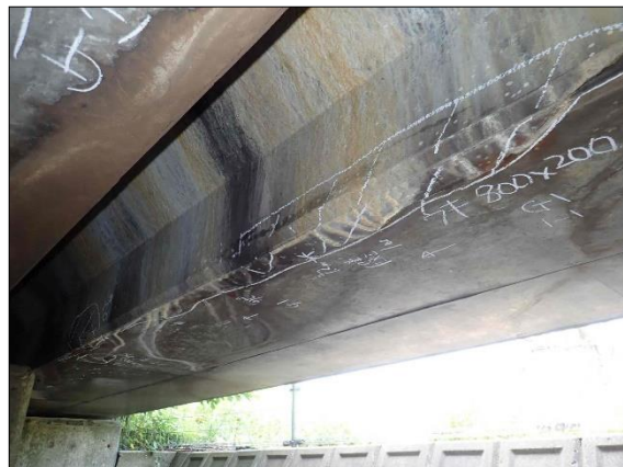
ひびわれ幅1.2mm, ひびわれの段差1.0mm
