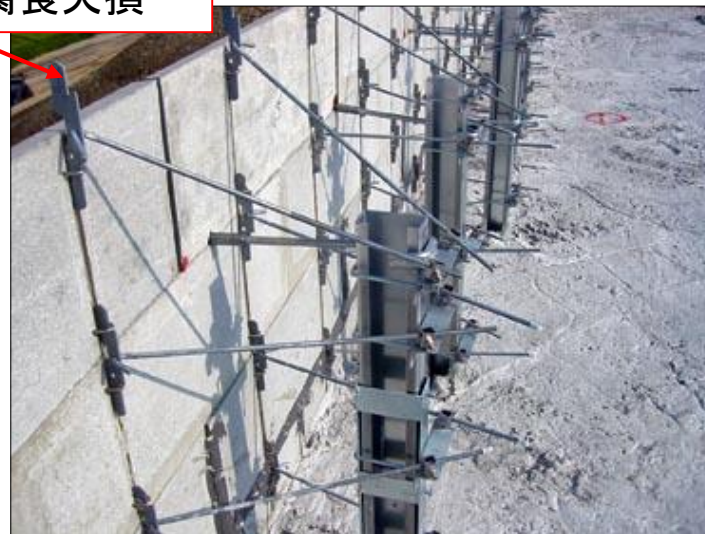
壁面パネル固定状況
