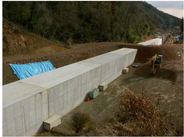
試験施工に使用したボックスカルバート（北山田2号水路函渠）
