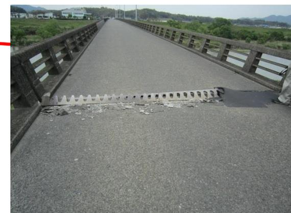
田口橋(県道御船甲佐線)(甲佐町) 伸縮装置損傷等
