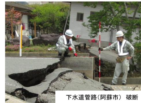
下水道管路(阿蘇市) 破断
