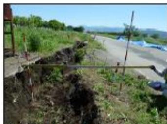
⑦ 開口亀裂及び陥没 W=140cm、D=125cm
