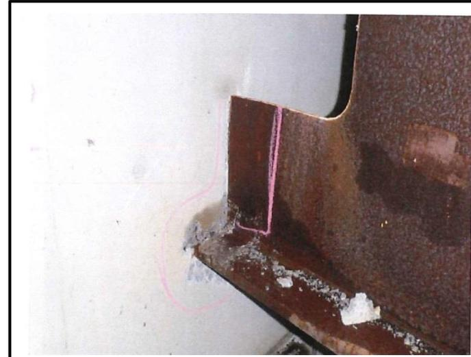
主桁、橋台接触による変形
