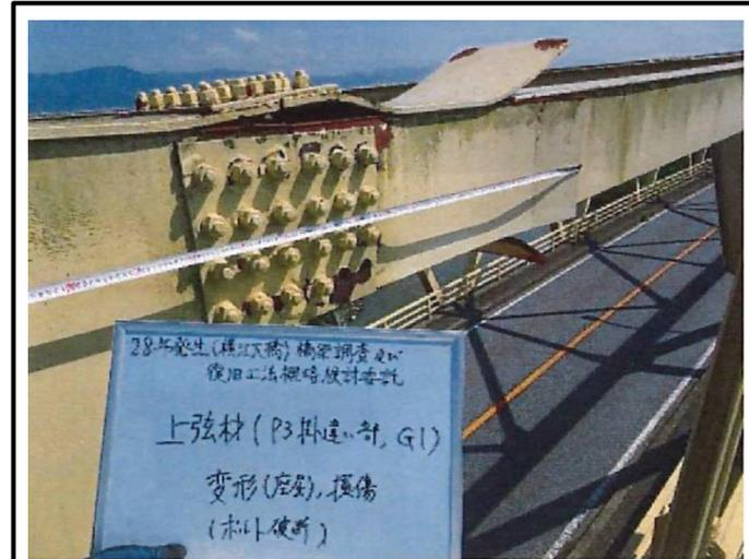
上弦材: 変形・破断・ボルト脱落
