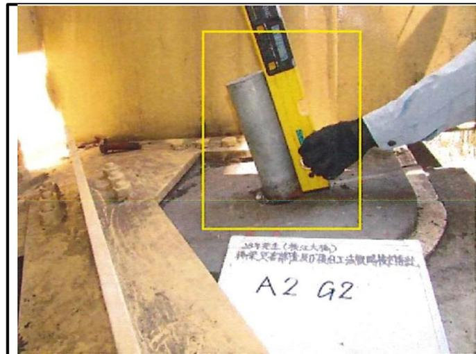
変位制限装置: アンカーボルト変形
