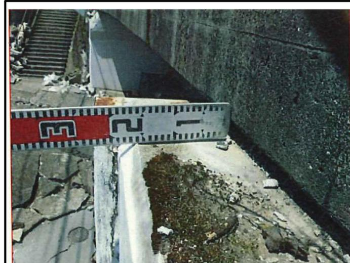
支承損傷、桁ずれ
