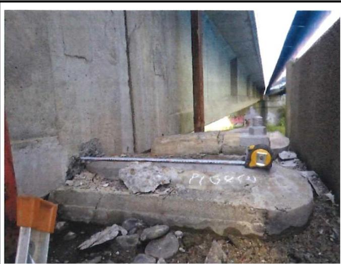
支承損傷、桁ずれ
