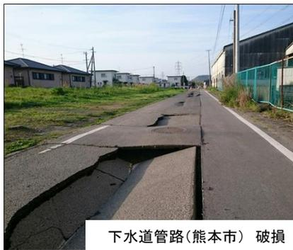
下水道管路(熊本市) 破損
