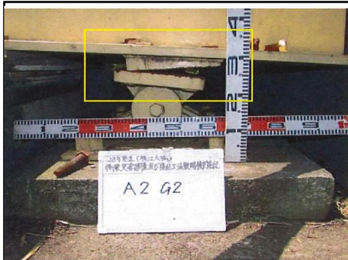
支承: セットボルト破断・回転
