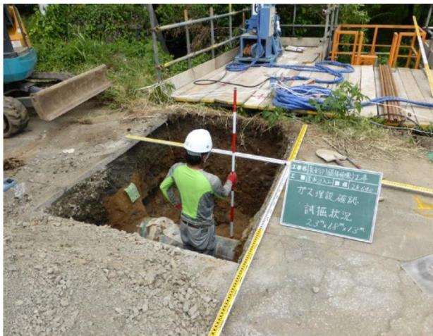
試掘状況(ガス管確認)
