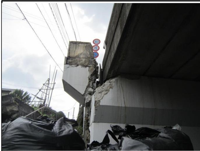
支承損傷、桁ずれ
