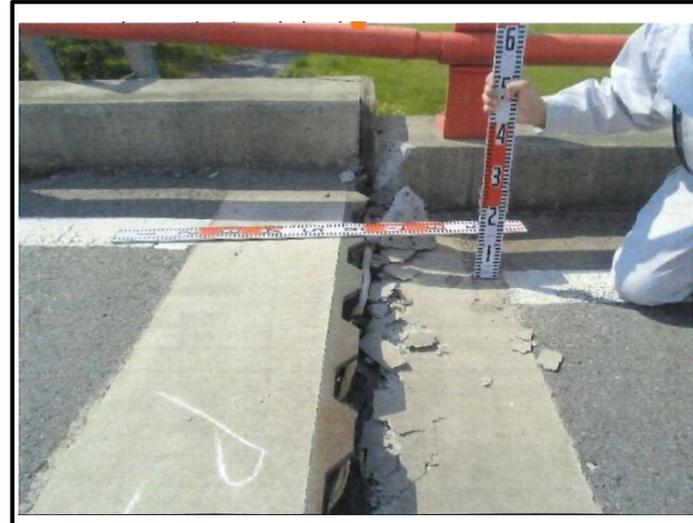
支承損傷、桁ずれ
