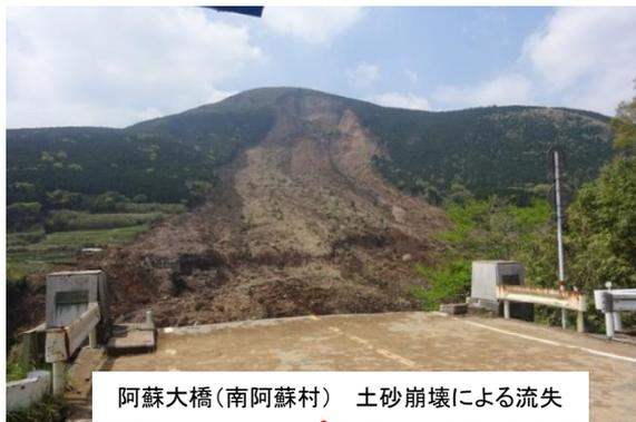
阿蘇大橋(南阿蘇村) 土砂崩壊による流失
