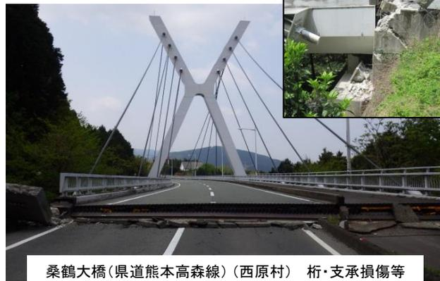
桑鶴大橋(県道熊本高森線)(西原村) 桁・支承損傷等
