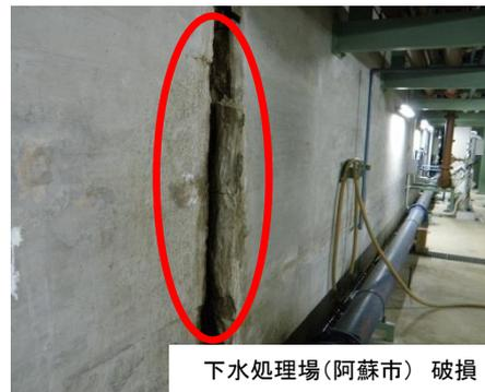
下水処理場(阿蘇市) 破損
