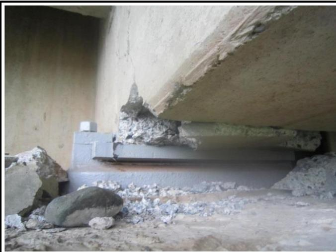
支承損傷、桁損傷
