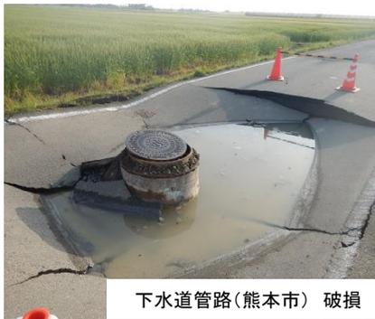
下水道管路(熊本市) 破損
