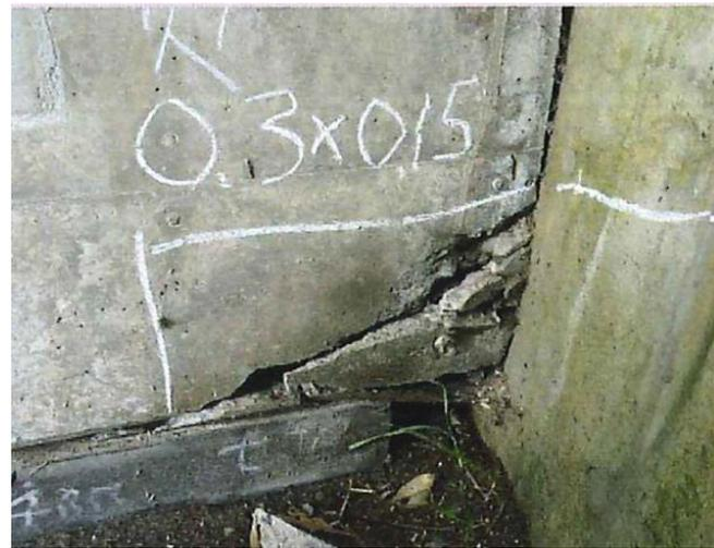
桁端部ひび割れ
