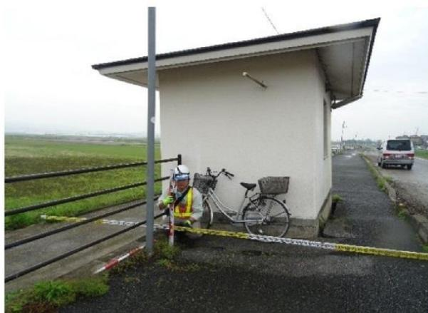
操作小屋沈下 (30cm)、大きく傾斜
