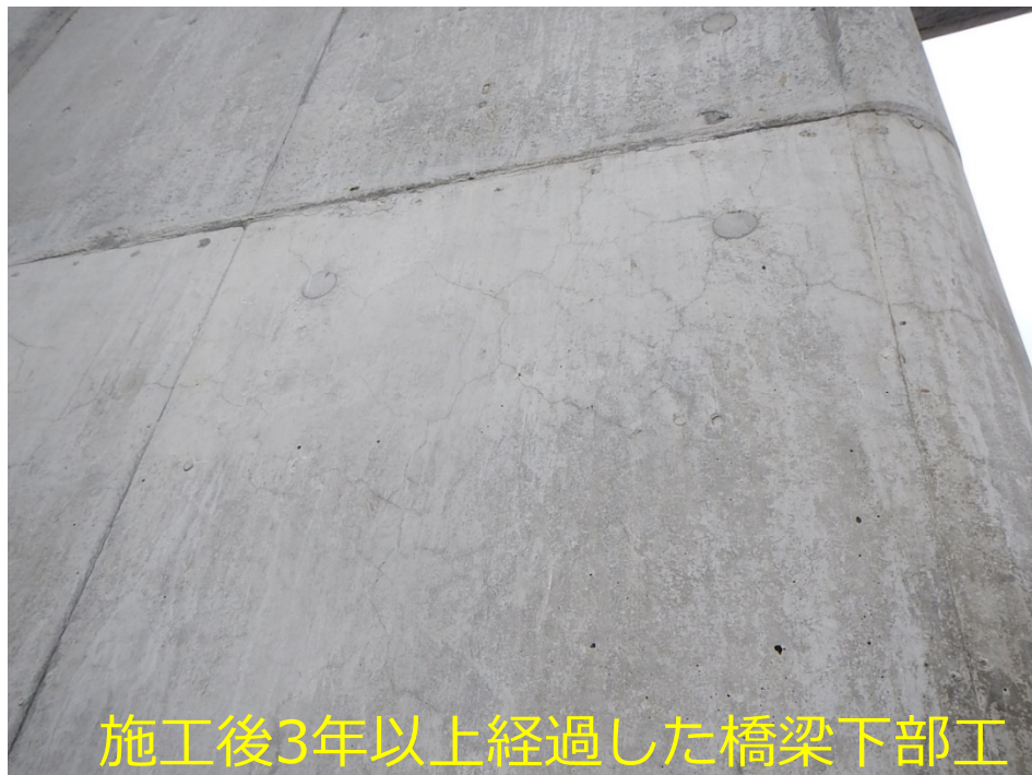
完成時には見られなかった 微細なひび割れ
