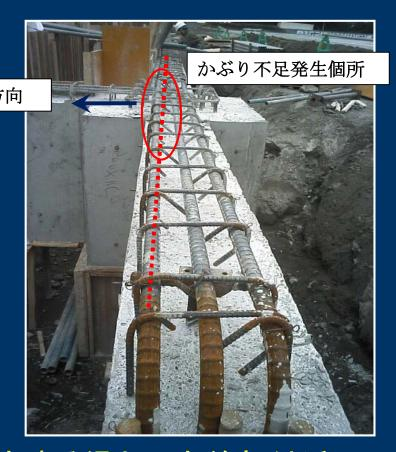
側(写真の左方向)に動き、<u>この梁と直交する梁との交差部付近に</u> おいては、鉄筋のかぶり不足が生じたものである。
