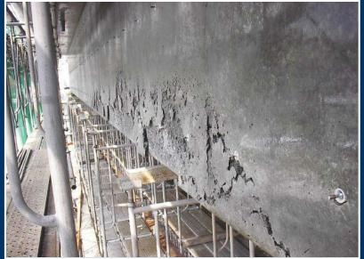
この変状が生じた位置は主桁のスパン中央に近い部分であり、主桁側面下端部に長さ約4.0m、高さ約0.7mの範囲に渡ってはらみや表層コンクリートの剥離が生じていた。はらみの生じた桁幅の状況を図に示すが、主桁下面の左右におけるはらみの最大値はそれぞれ47mmと42mmであった。
