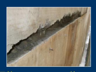
した時、<u>躯体外側の打継目10数mに亘って、幅約1cmのスリット状の空洞とその上部4~5cmの幅の黒っぽい変色層</u>が発見された。打音検査で濁音があったため、奥行き方向にはつり調査したところ、鉄筋を超える深さにまで空洞と脆弱層が認められた。
