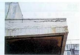
写真-3 長手方向ひび割れ
