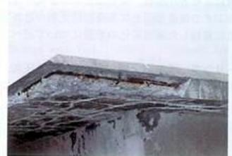
写真-5 剥落・崩壊
