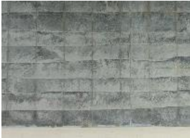
打重ね線が目立つが補修箇所なし
