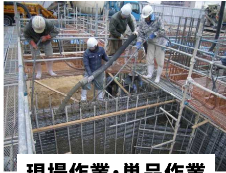
現場作業・単品作業
