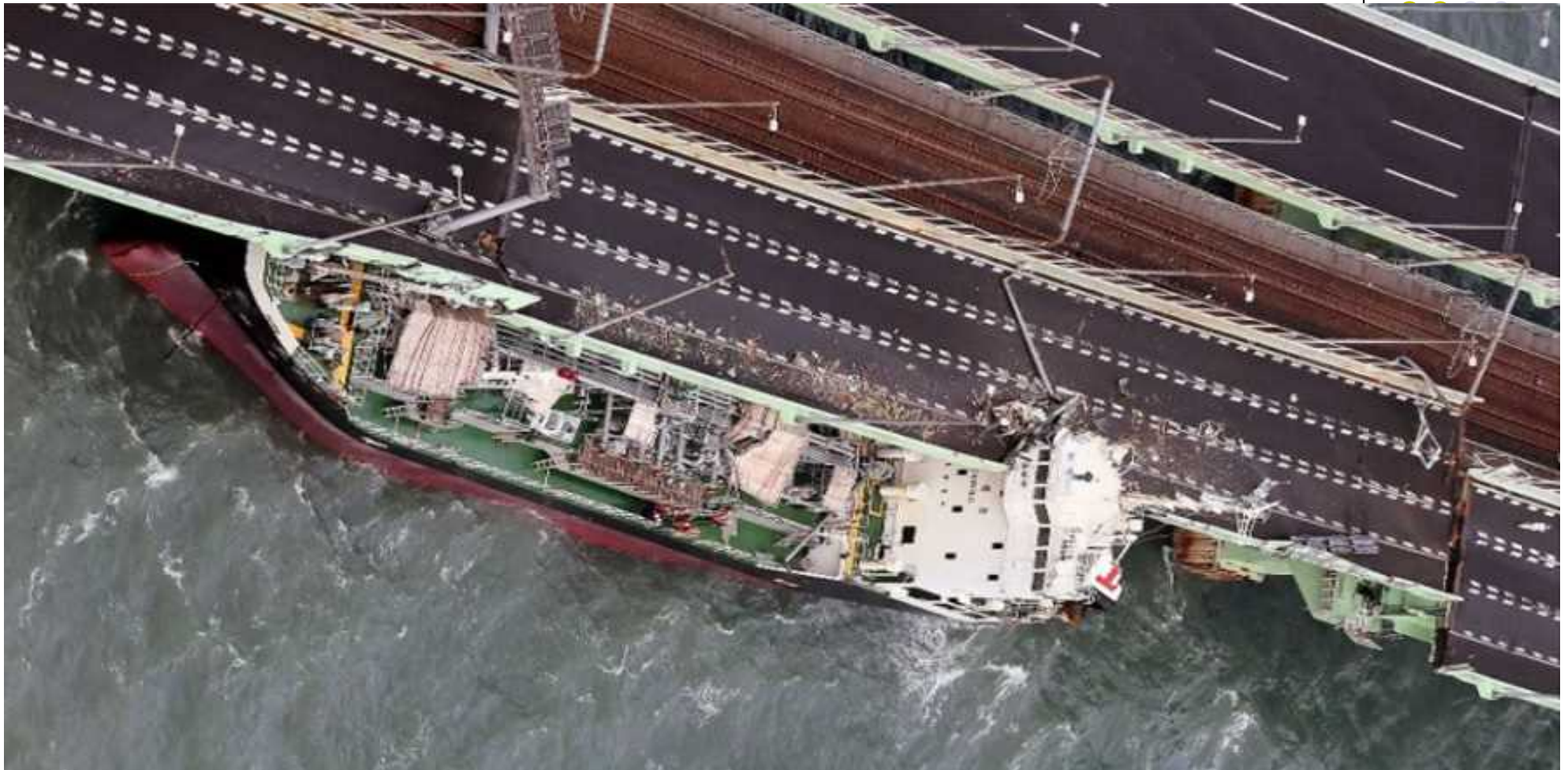
関空連絡橋 タンカー衝突:2018/9/5
