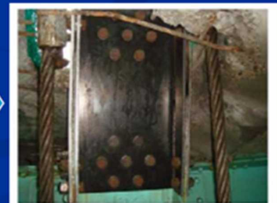
破断箇所の応急復旧状況
