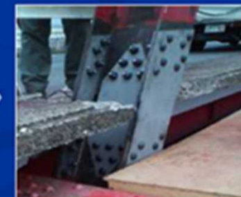
補修後の状況
